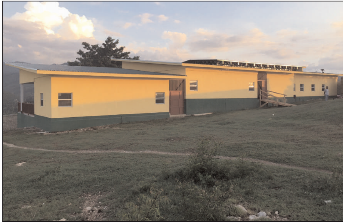
Installations médicales construites à Carrefour par Veehouse Voda Haïti.
