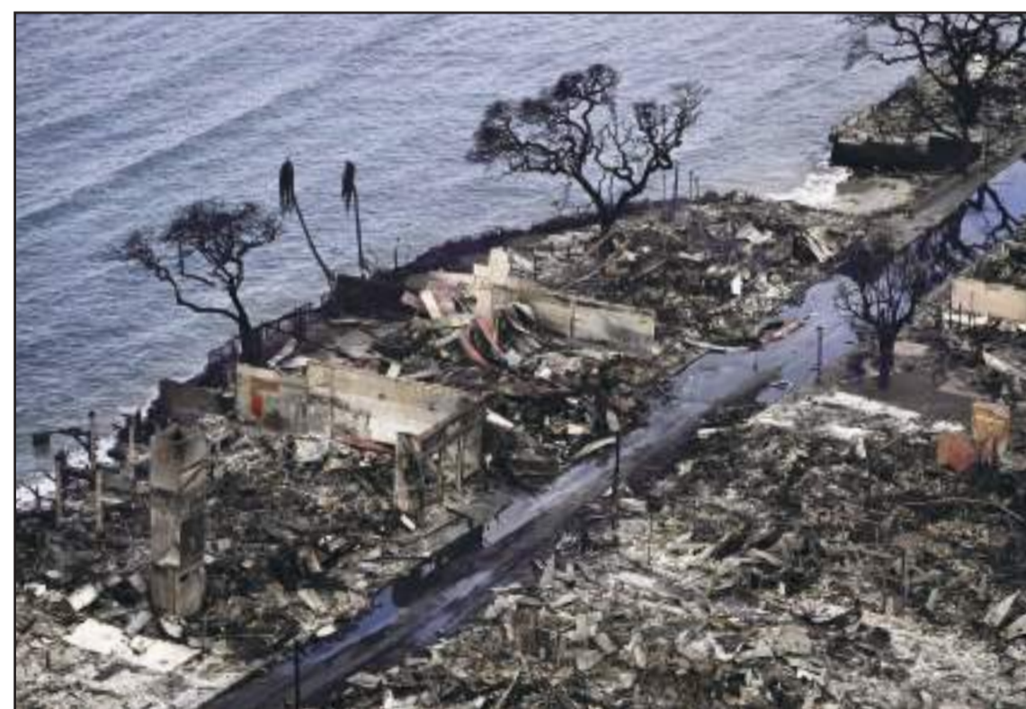
Une partie de la ville de Lahaina vue de l'air.
