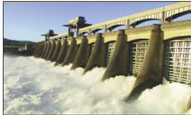
Le sabotage du barrage de Péligre avait entraîné l'inondation des terres cultivables de la région de l'Artibonite.
